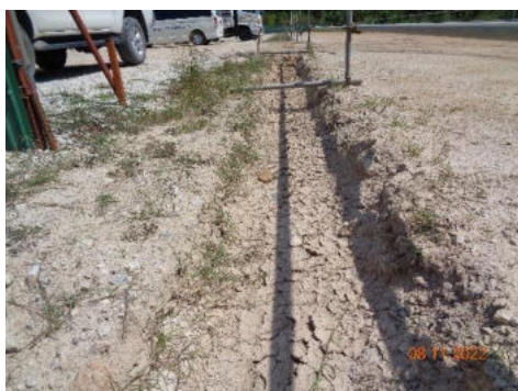
ภาพที่ 2.2-8 รางระบายน้ำชั่วคราว รอบพื้นที่ก่อสร้าง
