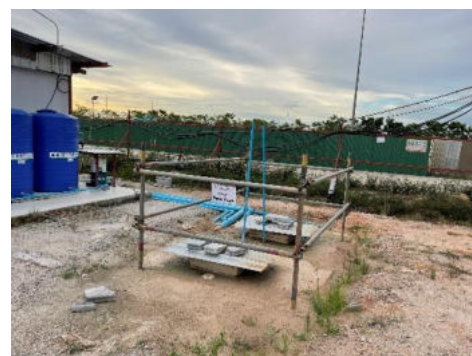
ภาพที่ 2.2-9 ถังกรองทราย (ระบบกรองทราย) ในพื้นที่ก่อสร้าง
