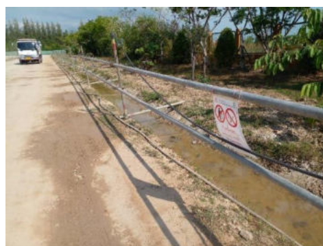
ภาพที่ 2.2-13 รางรวบรวมน้ำฝนในพื้นที่ก่อสร้าง
