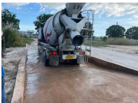
ภาพที่ 2.2-3 การทำความสะอาดล้อรถบรรทุก
