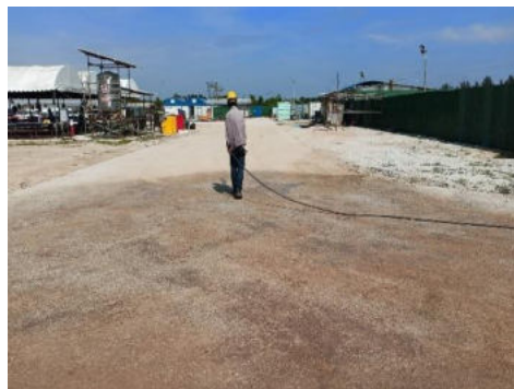
ภาพที่ 2.2-1 การฉีดพรมน้ำในพื้นที่ก่อสร้าง และทางเข้า-ออก พื้นที่ก่อสร้าง
